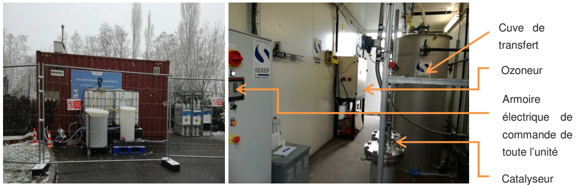
Figure 12 : Unité pilote mobile intégrée dans un container utilisée dans le cadre du projet BIOTECH, sur le site du CHU Source des données : SEREP-Technavox
