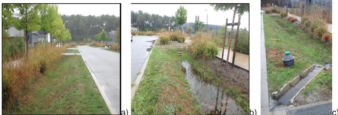
**Figure 28** Photos illustrant la noue par temps sec (a), après une pluie (b) et un petit canal d'amenée des eaux de voirie vers la noue (c).
