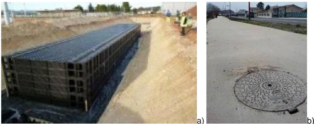
**Figure 32** Photos illustrant l'intérieur (a) et l'extérieur d'une SAUL une fois la construction finie (b).
