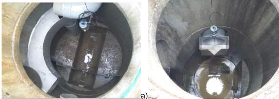
Figure 64 Installation des débitmètres aux points de mesure amont (a) et aval (b) de la SAUL avenue de la Boétie.
