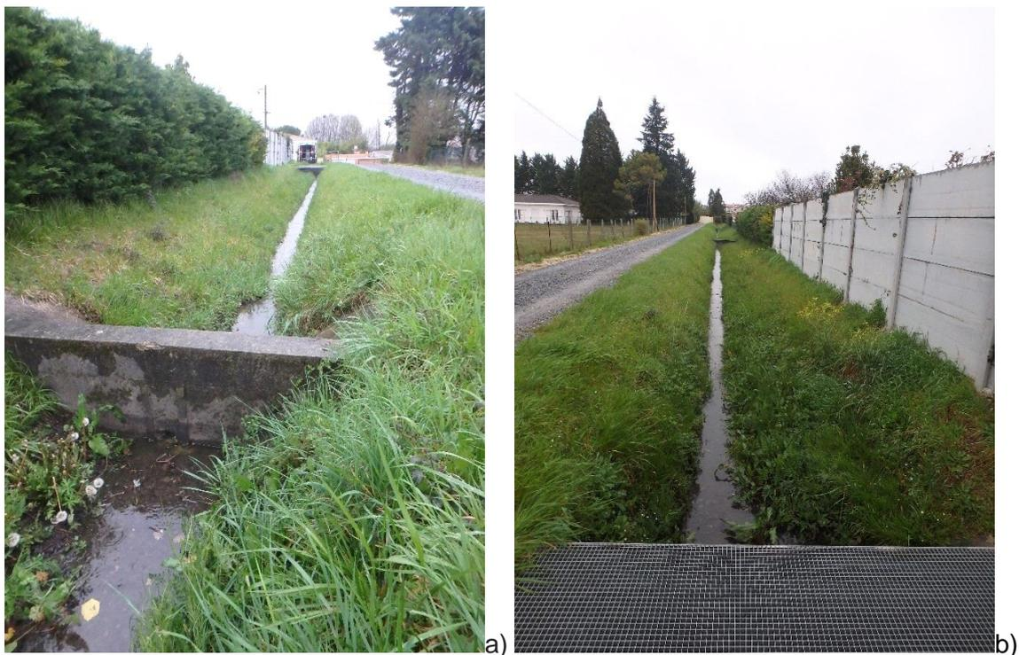
Figure 30 Photos illustrant la rétention de l'eau via un redent régulé (a), et la sortie de la noue (b) du Clos Lacaussade.
