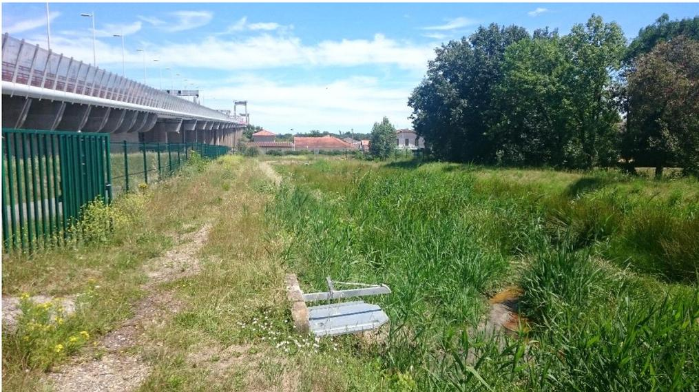
**Figure 18** Bassin de rétention des eaux pluviales issues des voiries de la rocade situé au niveau du pont d'Aquitaine (bassin n°3).
