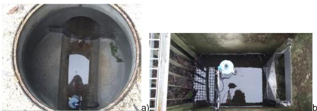
**Figure 62** Installation des débitmètres aux points de mesure amont (a) et aval (b) de la noue du Clos Lacaussade.
