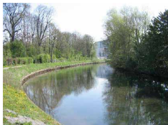
Protection de berges en palplanches avant travaux de restauration des berges. Automne 2010
