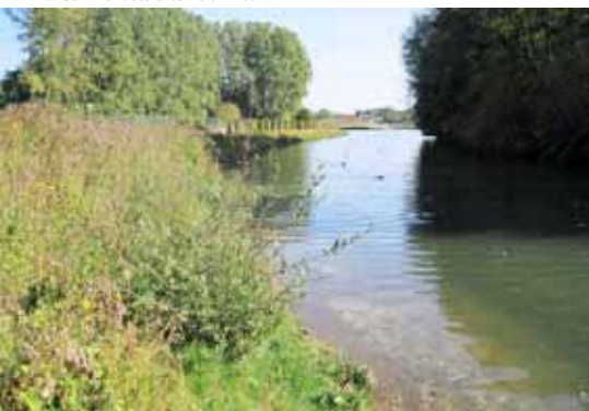
Aménagement des berges par retalutage et installation de plantations. Automne 2012
