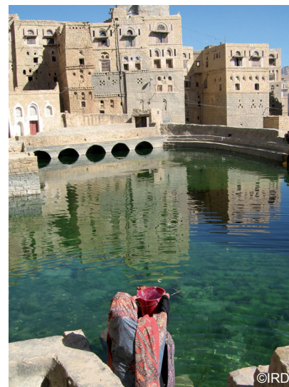
Comblant les écarts pour l'eau.
