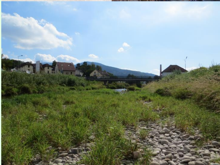
Berges enrochées de la Moselotte en aval du pont de Zainvillers à Vagney (à gauche), berges restaurées (à droite, photographie prise de l'autre berge).
