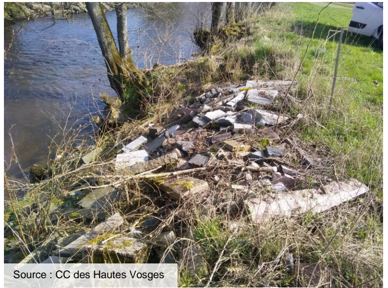
Enrochements composés de granites.
