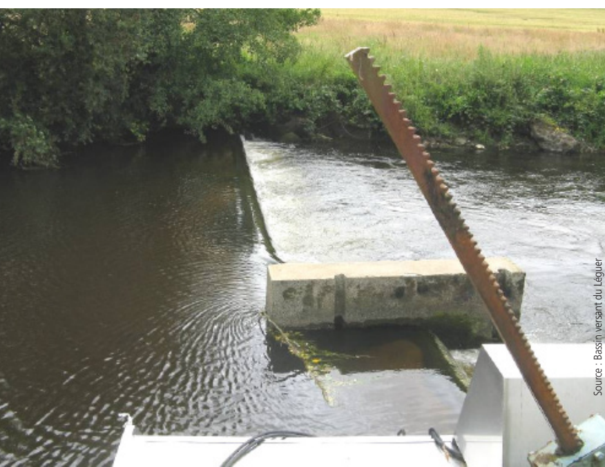
Seuil et prise d'eau avant travaux: légère échancrure au milieu et vanne amovible en rive gauche.
