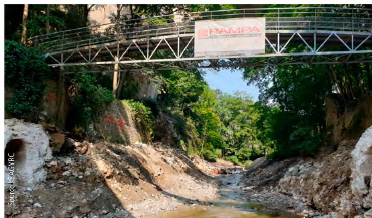
Effacement du seuil de la Roussille en cours en 2021. La suppression du seuil implique la déviation de la canalisation d'eaux usées. Une rampe à enrochement à 4% sera également mise en place pour éviter l'érosion des berges.
