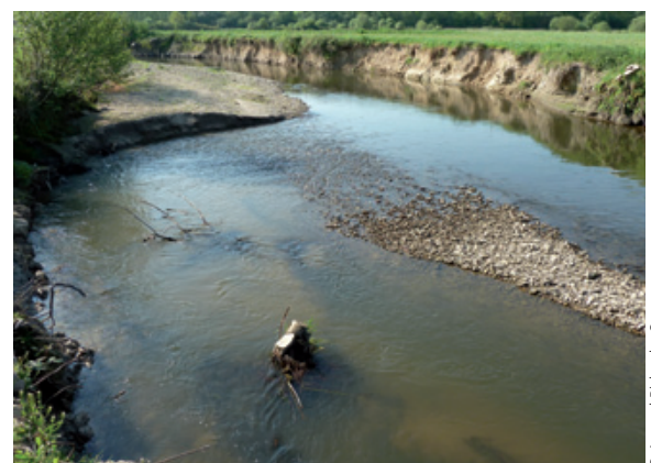
Remobilisation des sédiments dans l'ancienne retenue après effacement de l'ouvrage. Avril 2011
