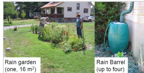
**Figure 17** : Dispositifs installés dans le cadre du projet pilote « *The Shepherd Creek expérience* », les trop-plein des récupérateur d'eau de pluie étant dirigé généralement vers le jardin (source : *Shuster et al., 2010*).
