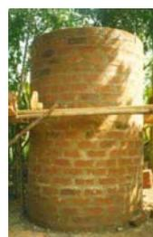
**Figure 49 :** Puits de pierre (soil block tank) (source : DTU)
