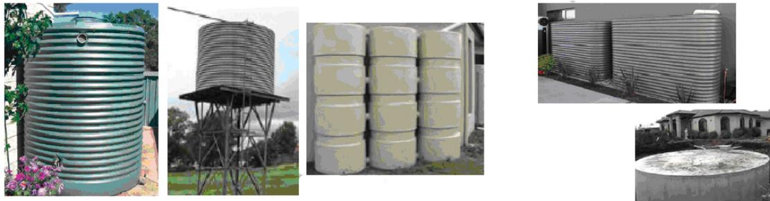
**Figure 24 :** Exemples de cuves d'eau de pluie couramment utilisées (source : de gauche à droite, de haut en bas : Government of Western Australia, Queensland Building Service Authority x 3, Aquaplate).
