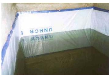
**Figure 44 :** Bâche de stockage (tarpaulin tank) (source : DTU)
