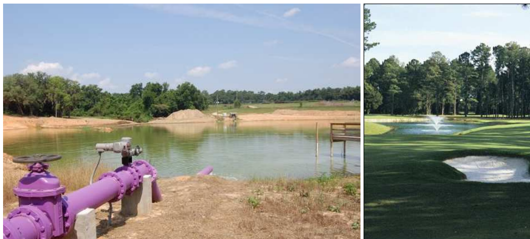
Figure 23 : Réservoirs opérationnels ouverts
