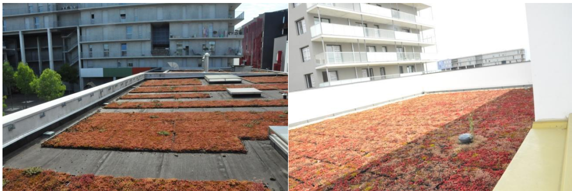
FIGURE 12: Toitures végétalisées de l'école (à gauche) et de Nantes Habitat (à droite)
