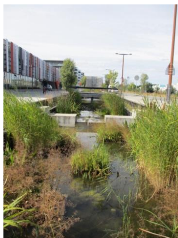
FIGURE 13: Canal de rétention
