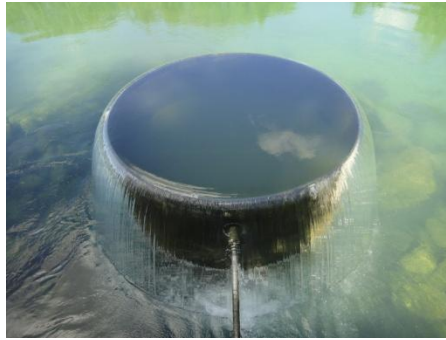
Illustration: Photographie d'une buse permettant l'alimentation d'un bassin d'infiltration du site
