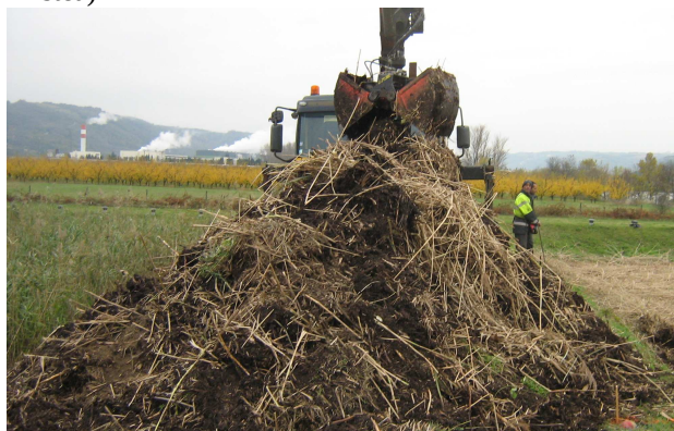
Curage sur casier déblais-remblais (crédit photo : Irstea)
