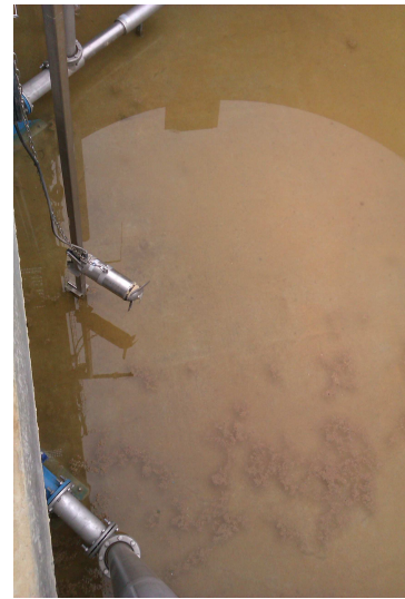
Figure 18 : photos de la cuve de stockage (6 jours) avec agitateur et hydroéjecteurs de la station de Nègrepelisse (11 000 m 3 /an)
