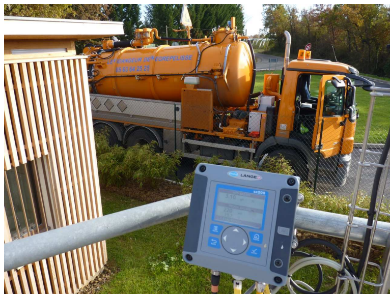
Station de Nègrepelisse (Crédit photo : Communauté de Communes Terrasses et Vallée de l'Aveyron)
