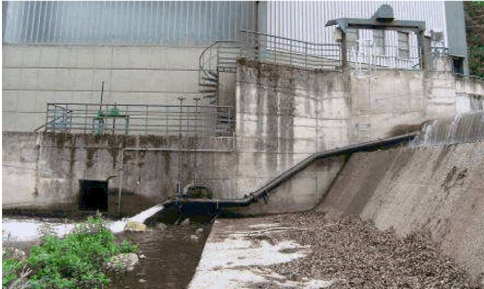
Figure 17 : Exemple de conduite en charge par syphon.
