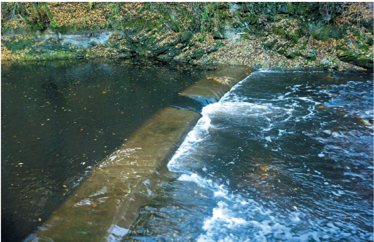
Le seuil en 2009, après travaux : la continuité écologique est retrouvée.
