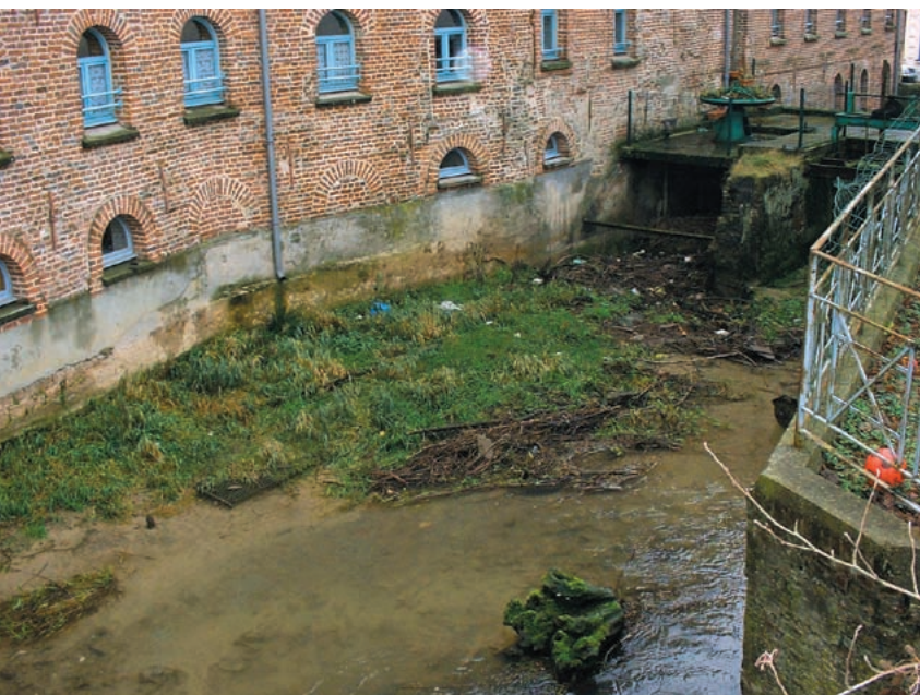
L'ouvrage faisant obstacle à la continuité de la Canche à Hesdin, vu de l'amont.
