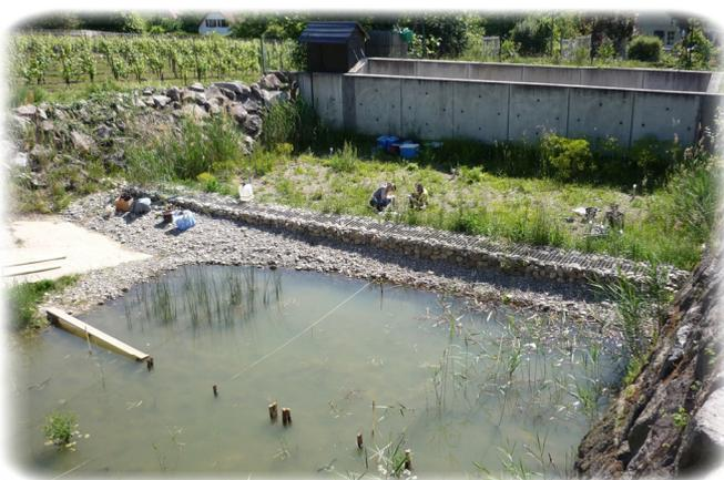
L'enquête a concerné la mise en œuvre de la double fonctionnalité (régulation des débits d'eau et traitements des flux de pollution) au sein d'un même ouvrage : un bassin d'orage converti en ouvrage de rétention à l'exutoire d'un bassin versant viticole.
