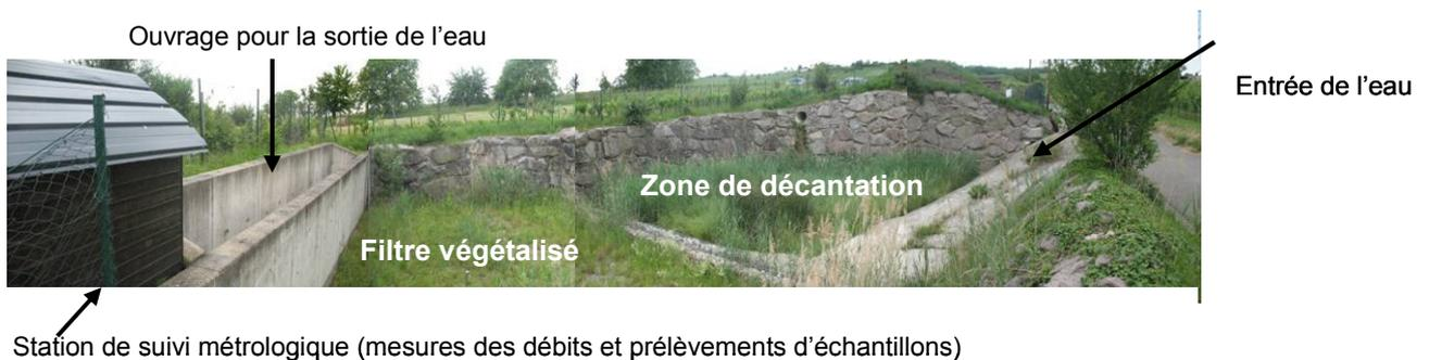
**Schéma 7: Exemple de zone humide artificielle ArtWET : bassin d'orage à Rouffach, France (C. Grégoire)**
