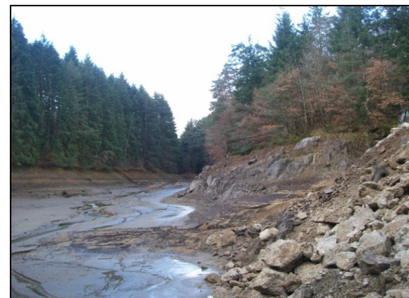
Le Bosançon, 2 barrages de 5m (2012)
