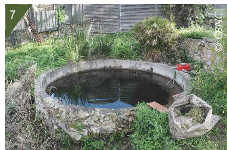
7 - Le bassin de Lumiu après intervention.
