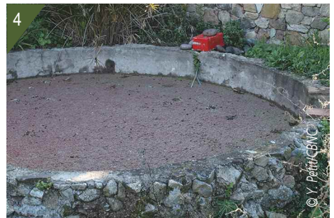
3 - Colonisation du Reginu par Azolla filiculoides . 4 - État initial du bassin envahi à Lumiu.
