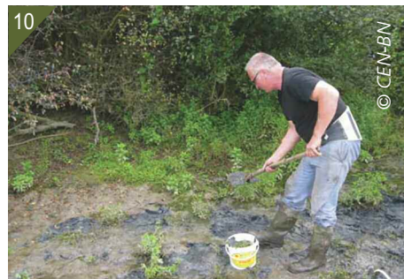
9 - Travaux de comblement du bras mort : bras mort entièrement comblé. 10 - Etrépage manuel.
