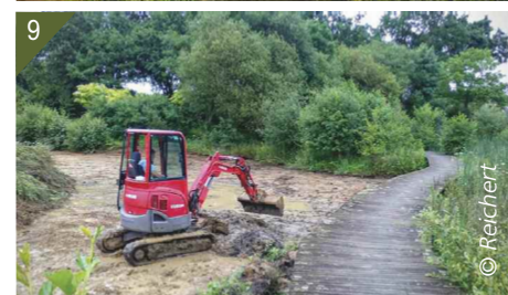
4 et 5 - Étang Acigné 02 avant intervention. 6 - Arrachage mécanique sur l'étang Acigné 02. 7 - Dispositif de filtration à la pompe sur l'étang Acigné 02. 8 et 9 - Curage sur l'étang Acigné 02.
