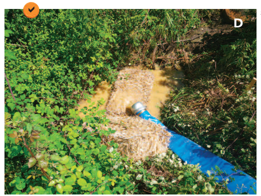
C, D - Exemples de deux dispositifs temporaires de protection des exutoires (utilisés pour quelques jours uniquement). L'option « botte de paille » n'est pas la plus économique ni la plus efficace.
