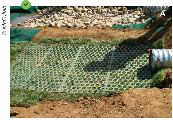
A, B - Protection d'un point de rejet à l'aide d'un tapis laminaire PEHD. Le tapis favorise l'étalement de la lame d'eau et dissipe l'énergie hydraulique. Les faibles turbulences à la surface de l'eau permettent la reprise végétale, protégeant d'autant plus efficacement les sols contre l'érosion.
