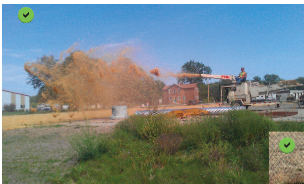
Exemple d'un paillage en cours.
