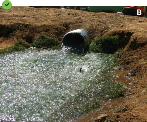
A, B - Protection d'un point de rejet à l'aide d'un tapis laminaire PEHD. Le tapis favorise l'étalement de la lame d'eau et dissipe l'énergie hydraulique. Les faibles turbulences à la surface de l'eau permettent la reprise végétale, protégeant d'autant plus efficacement les sols contre l'érosion.
