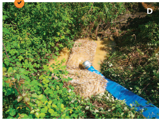
C, D - Exemples de deux dispositifs temporaires de protection des exutoires (utilisés pour quelques jours uniquement). L'option « botte de paille » n'est pas la plus économique ni la plus efficace.
