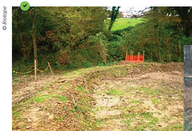
Merlon en bas de pente, équipé d'une surverse (identifiée en orange). Il protège une berge défrichée et dirige l'eau vers un milieu végétalisé
