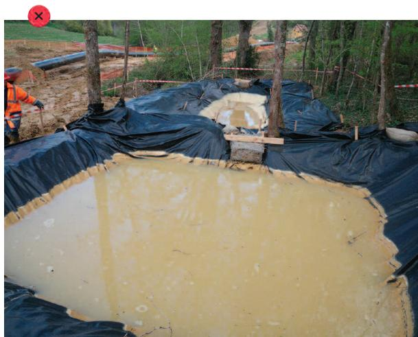
Bassin de décantation inefficace : forme inadaptée ne diminuant pas suffisamment la vitesse du courant et les turbulences hydrauliques.
