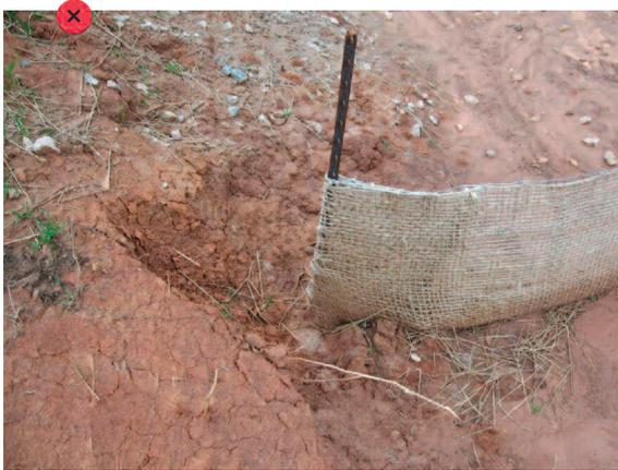
La mauvaise disposition des barrières entraîne des contournements et des processus d'érosion des talus.
