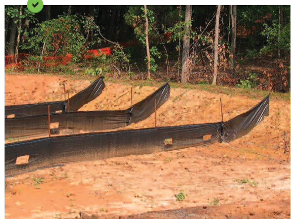
Fixation correcte des barrières géotextile.
