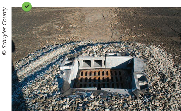
Type 3 : enrochement drainant qui permet une rétention de l'eau chargée et un écoulement réduit dans le réseau. Les deux dispositifs sont construits avec parpaings à l'intérieur et un merlon en graviers autour.
