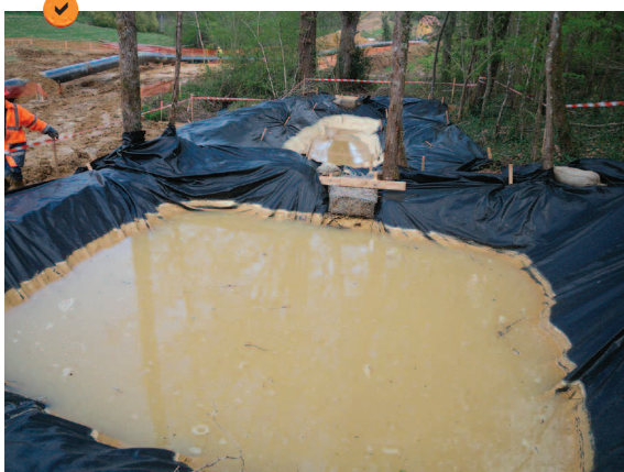
Dispositif de surverse à gabion de paille.
