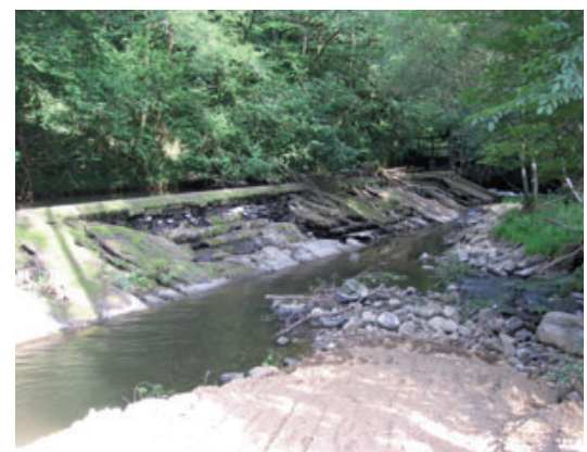
Le barrage du Martinet, avant travaux en 2007.
