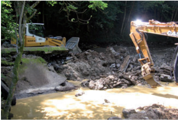
Destruction du barrage du Martinet. Juin 2011
