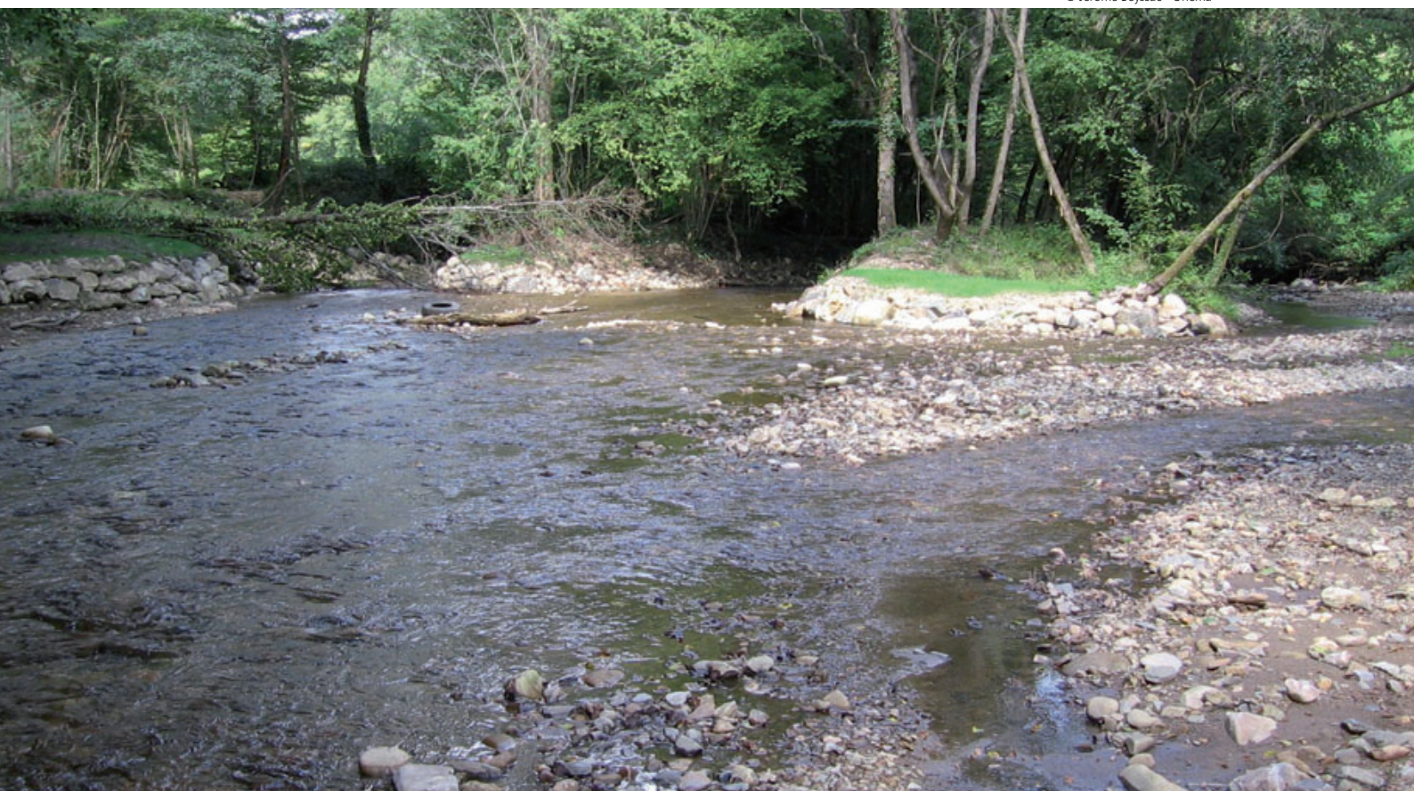
L'ancienne retenue en amont du seuil du Martinet, après les travaux. Automne 2011
