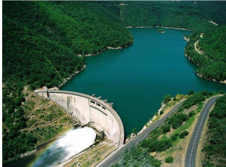
D'une hauteur de 62 m, le barrage des Monts d'Orb permet le stockage de 34,3 Mm<sup>3</sup> au niveau de la cote de retenue normale 432 mNGF. L'ouvrage contrôle un bassin versant de 125 km<sup>2</sup> (8 % de la surface totale de l'Orb) dont les crues maximales (T=1 000 ans) sont estimées à 1100 m<sup>3</sup>/s.
