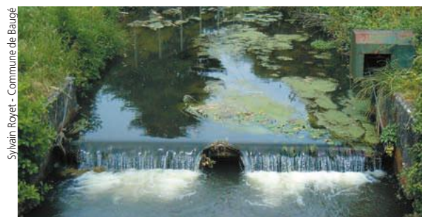
Seuil sur un cours d'eau (développement excessif d'algues dans la retenue du seuil).
