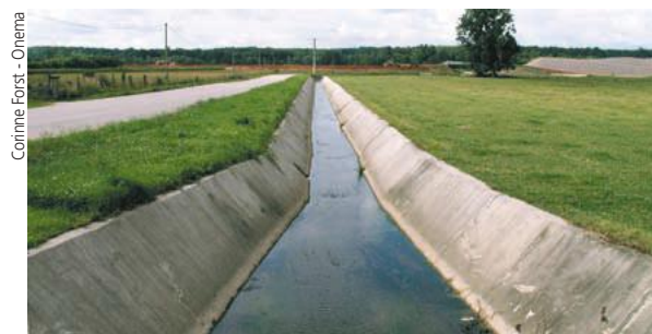
Exemples de cours d'eau dont la morphologie est altérée. À gauche : cours d'eau rectifié et bétonné (réduction de la hauteur d'eau, rupture des échanges avec la nappe d'accompagnement et le lit majeur, eutrophisation du cours d'eau et faciès d'écoulement homogènes). À droite : cours d'eau recalibré (faciès d'écoulement uniforme, début d'incision du lit).
