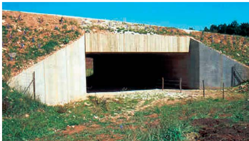
Passage à faune mixte « faune/chemin » sous l'A75 (Lozère).
