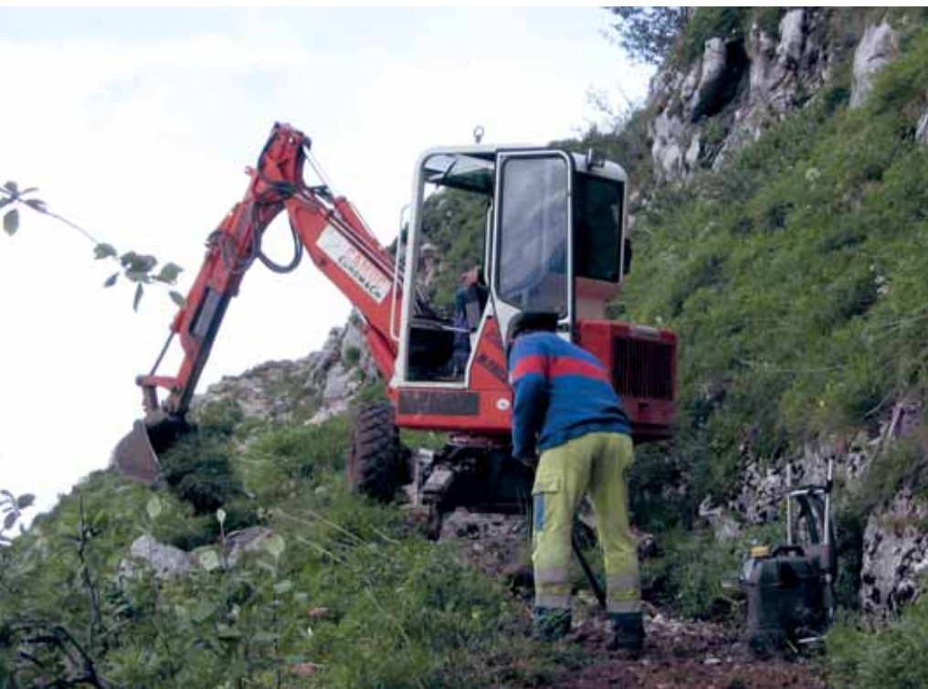
Restauration d'un sentier d'accès aux propriétés de l'ONCFS dans la Réserve des Bauges : élargissement et sécurisation préalable à la montée des génisses.
