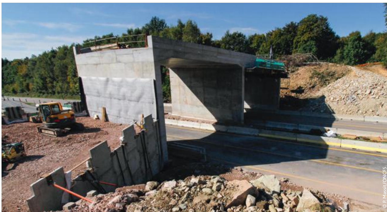
▲ Construction d'un passage à faune sur la RN 57 (Vosges, octobre 2010) en tant que mesure d'atténuation de l'impact de l'ouvrage routier sur la conservation des espèces protégées.
