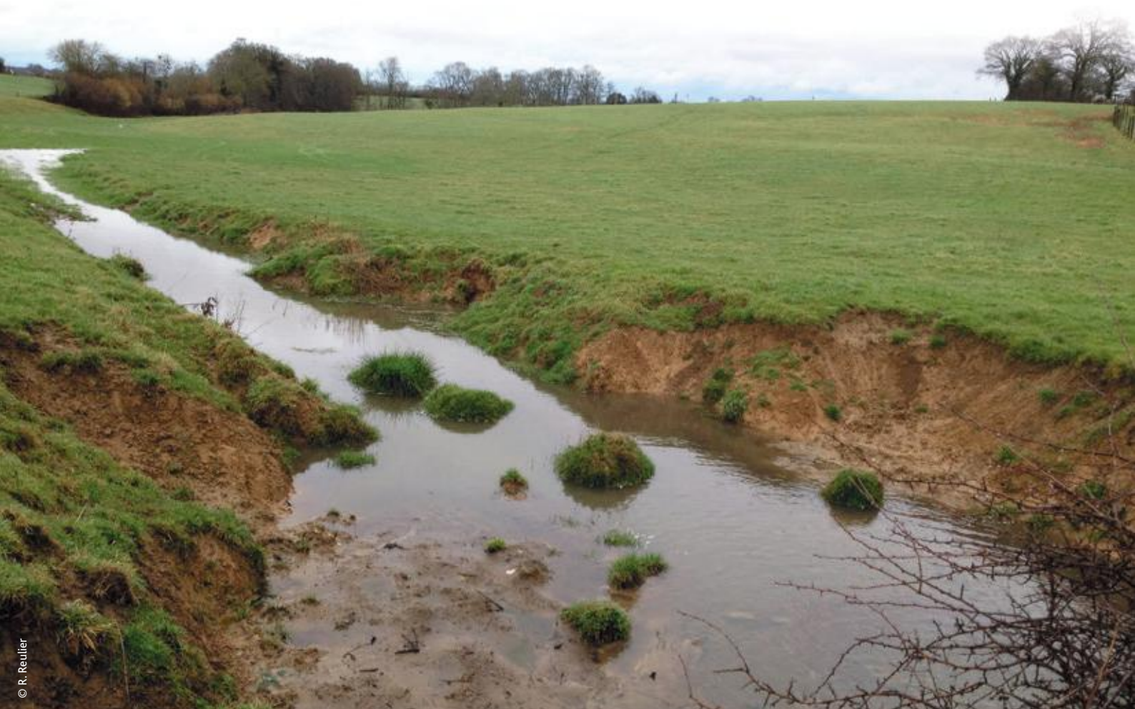
▼ Dégradation des berges par piétinement bovin.
