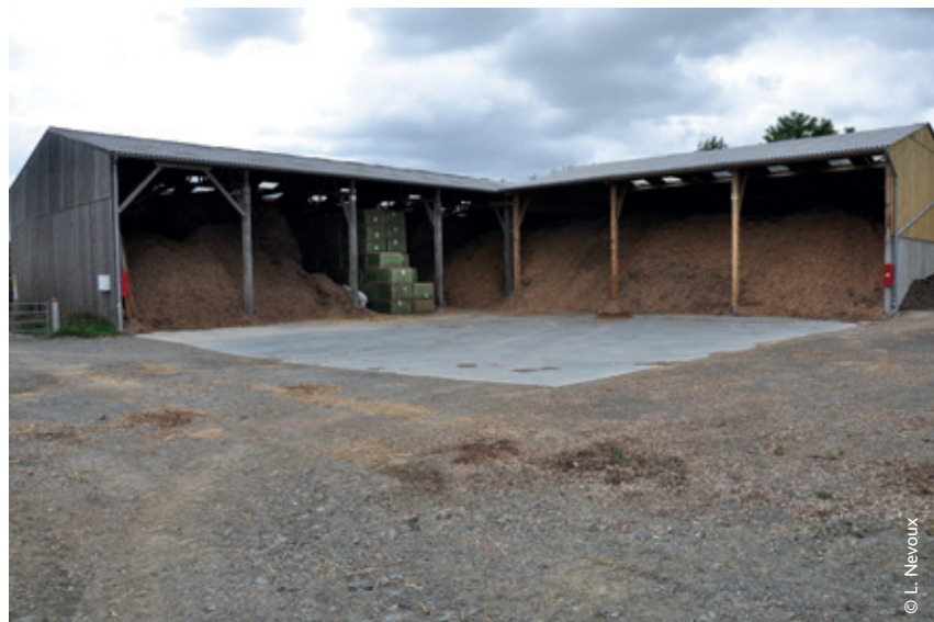
▼ Plateforme de stockage.
