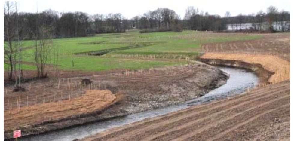
Opération « un nouveau lit pour la Veyle » (Bonfond 2010)
