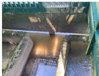
Ouvrage du plan d'eau permanent des Damoi- seaux sectionné à sa base pour laisser passer le flux en continu. Des vannes de gestion des crues sont maintenues. ©OFB 2024
