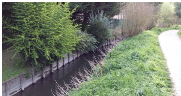
Site des Damoiseaux avant travaux. ©SIABV 2015
