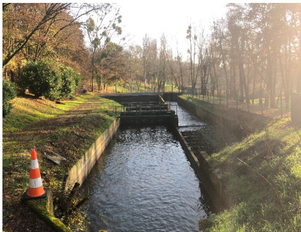
Bassin de décantation, avant suppression. ©SIAVB
