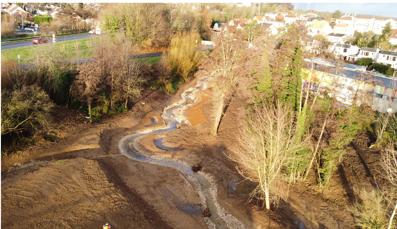
Petit ru de Vauhellan, pendant travaux ©SIAVB
