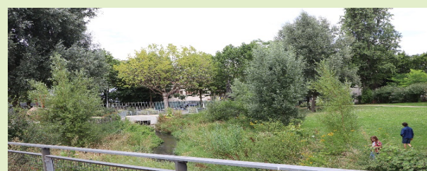
Tronçons 1, 2 et 3 après travaux, juillet 2024. ©OFB
