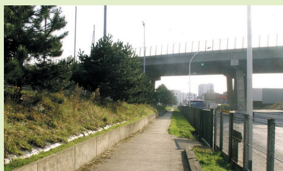
La Bièvre recouverte à Arcueil avant travaux. ©CD94
