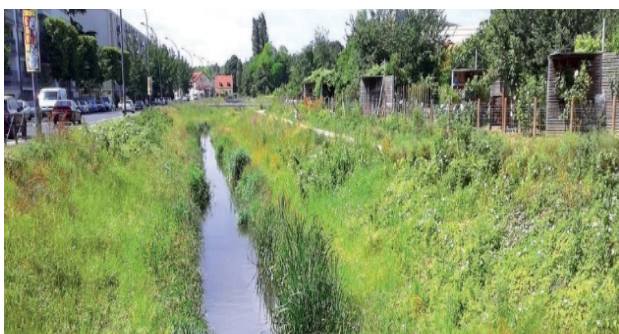
La Bièvre en juin 2017 à l'Hay-les-Roses, un an et demi après les travaux. ©OFB 2017
