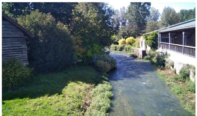
La Canche à Conchy-sur-Canche, avant (en haut) et après (en bas en 2023) démantèlement du vannage. Les rives mises à nu par l'abaissement de la ligne d'eau se sont rapidement végétalisées - © Sébastien Cosnier - DDAF du Pas-de-Calais
