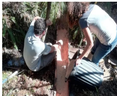
Figure 6 : a) Réalisation d'un bouchon mécanique avec géotextile ; b) Réalisation d'un bouchon manuel (planches + sciure/argile)
