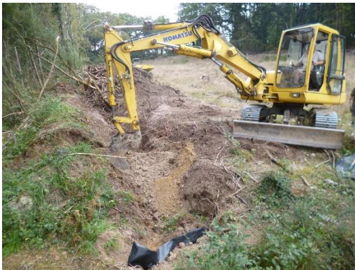
Figure 6 : a) Réalisation d'un bouchon mécanique avec géotextile ; b) Réalisation d'un bouchon manuel (planches + sciure/argile)
