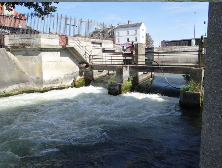
Barrage St Michel en septembre 2016, vue générale (en haut) et vue aval (en bas).
