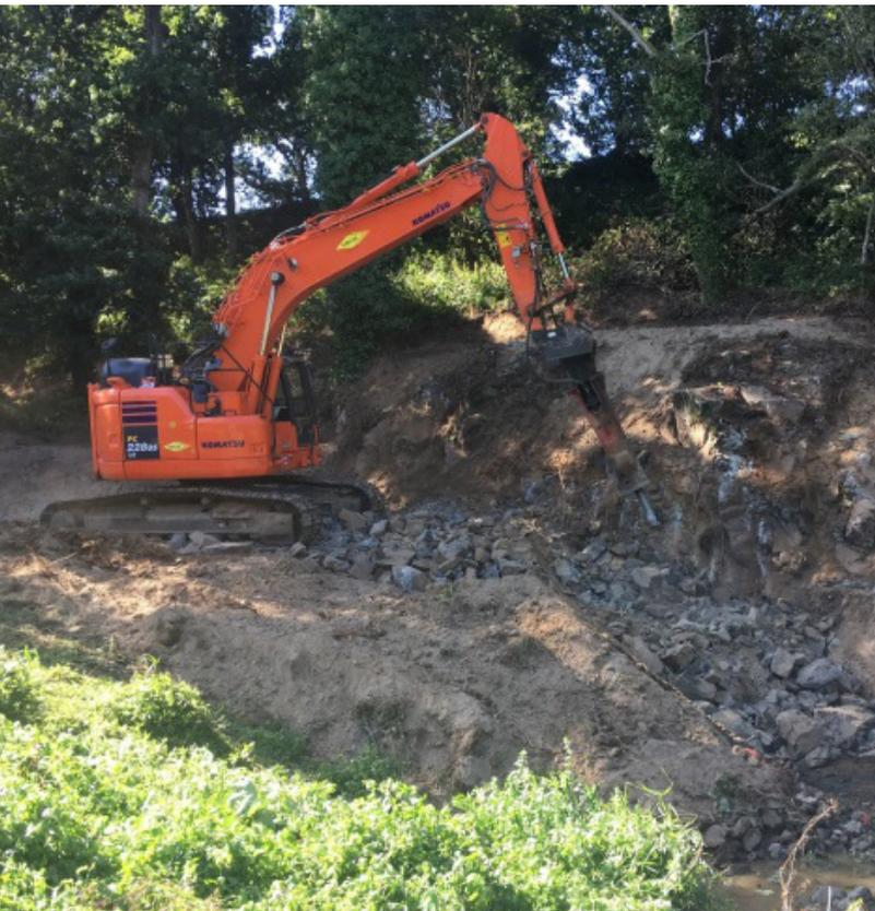
Les travaux ont nécessité un brise roche hydraulique pour l'affleurement rocheux.
