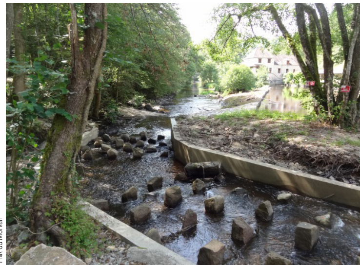
Rampe à enrochement sur le seuil du moulin Cadoux après travaux en 2017
