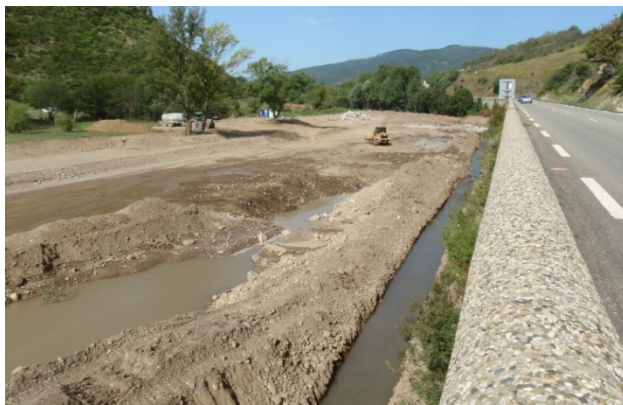
L'Ouvèze lors des travaux, 2011-2012 © F. Charrier, Sydeo
