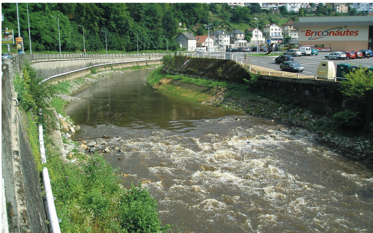
Le site après l'effacement du seuil en septembre 2008.
