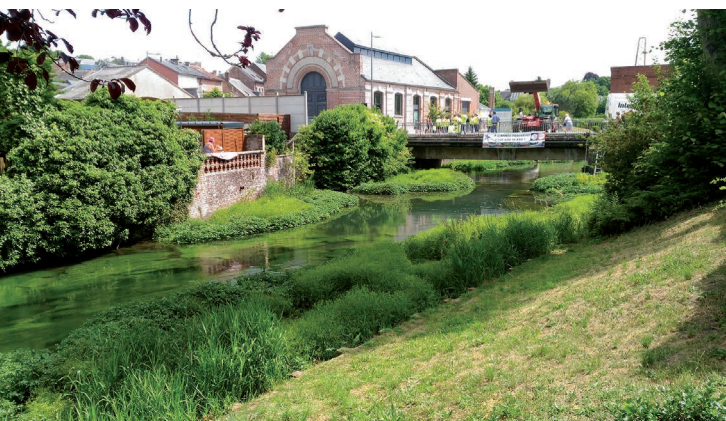
Évolution des banquettes en géotextile sur les berges au niveau de l'ancienne retenue. 2017.
