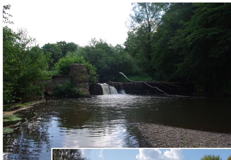
Seuil du moulin Vert avant travaux en 2016.
