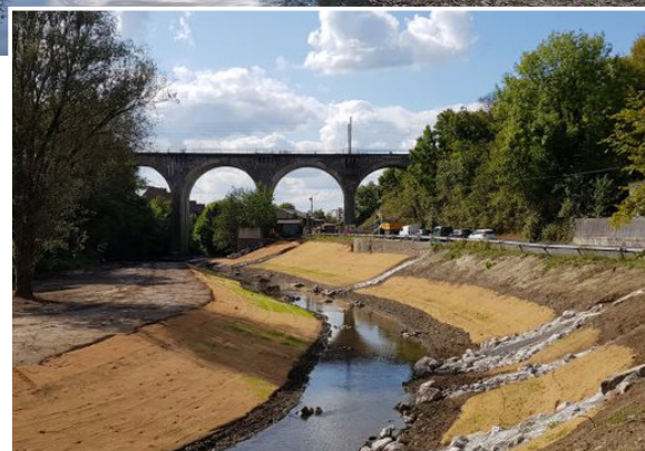
Amont du seuil Moulin Vert après travaux en 2019.
