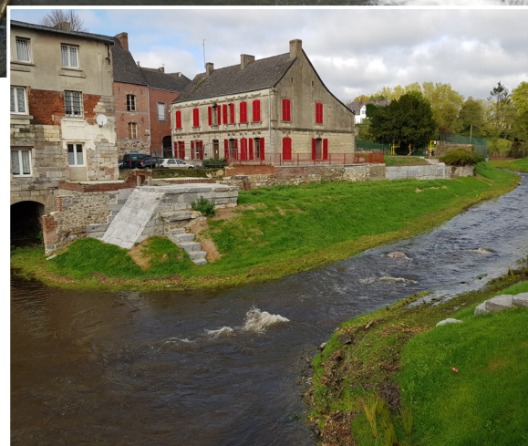
Seuil Pasteur après travaux en octobre 2019.
