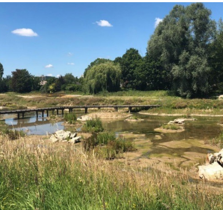
Photographie prise le 27 juin 2018 pendant les travaux (sentier de promenade et zone d'expansion des crues)
