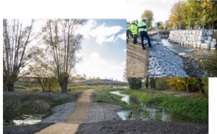
Création du nouveau lit après travaux.
