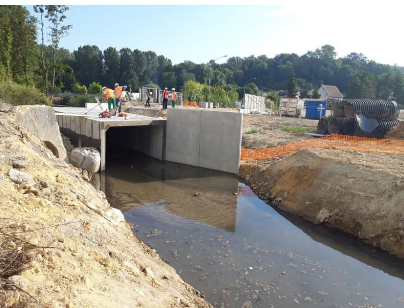
Construction d'un pont cadre transparent vis-à-vis de la continuité remplaçant le pont busé existant en 2019.
