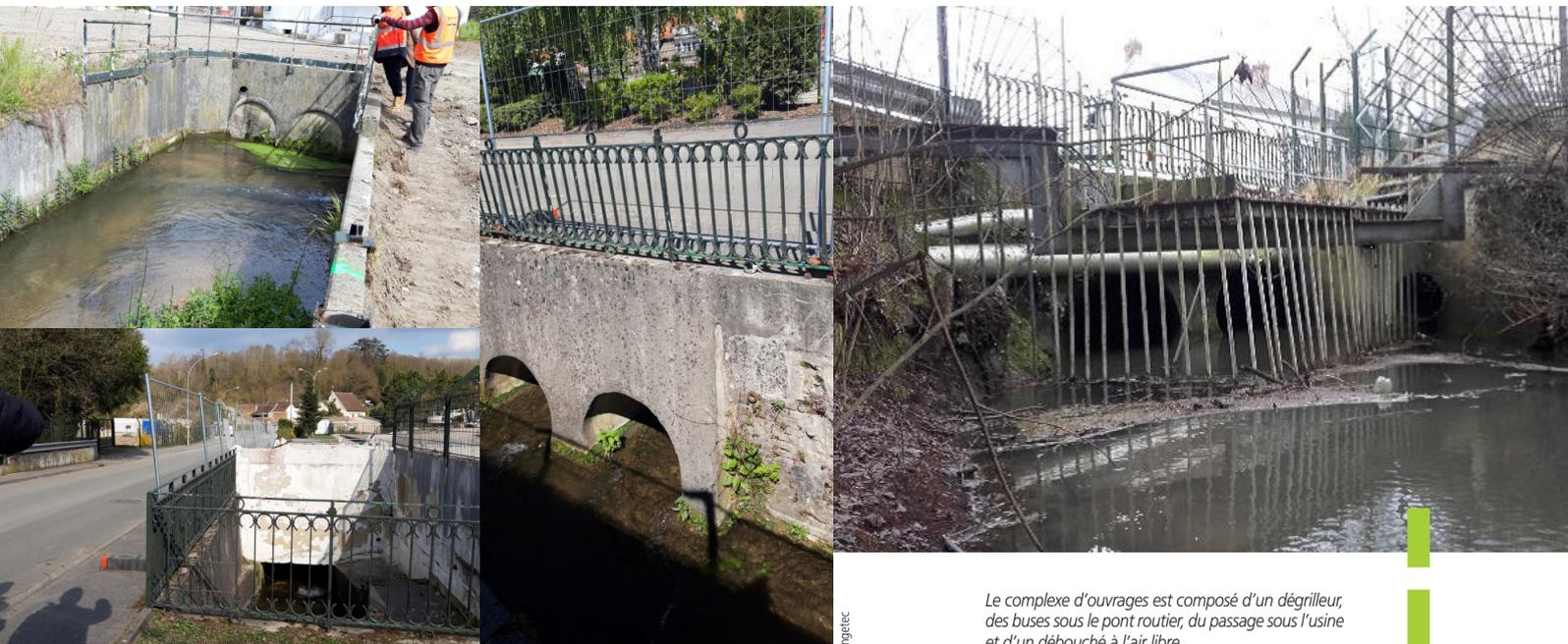
Le complexe d'ouvrages est composé d'un dégrilleur, des buses sous le pont routier, du passage sous l'usine et d'un débouché à l'air libre.
