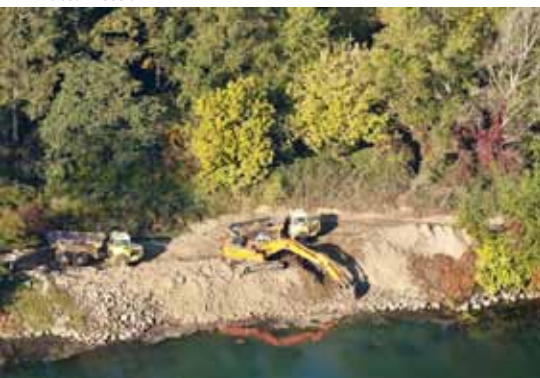
Ouverture de la digue Girardon sur le site de Cornas. Octobre 2011
