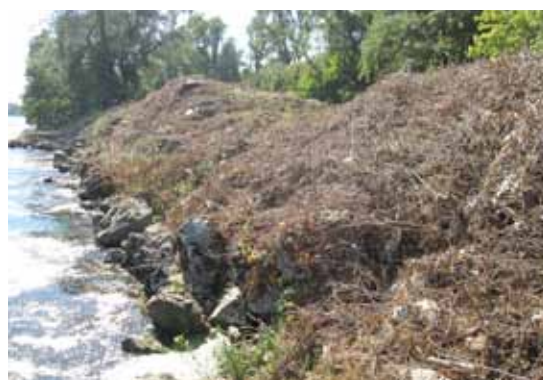
Ancienne digue Girardon présente sur le Rhône où s'accumulent les débris de crue, avant ouverture. Septembre 2011.
